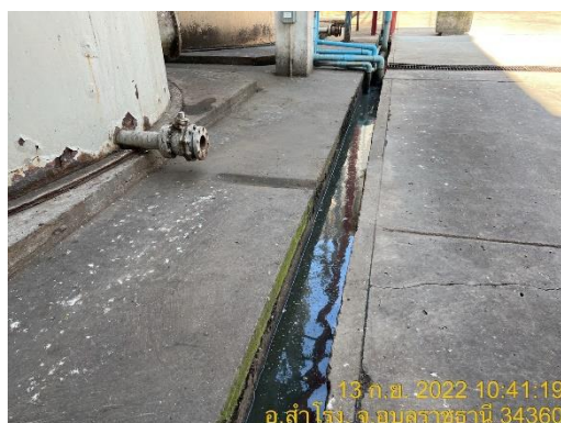
รูปที่ 36 รางรวบรวมน้ำฝนของโครงการ
