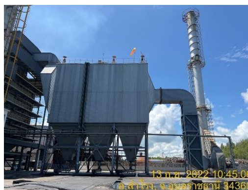
รูปที่ 5 ระบบดักฝุ่นแบบ ESP
