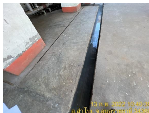
รูปที่ 36 รางรวบรวมน้ำฝนของโครงการ
