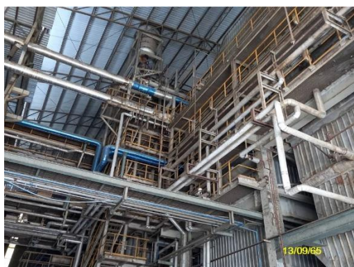
รูปที่ 2 หม้อไอน้ำขนาด 63 ตัน/ชั่วโมง (หม้อไอน้ำชุดที่ 1)
