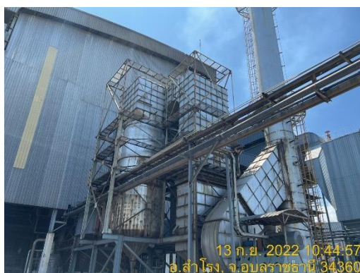
รูปที่ 4 ระบบดักฝุ่นแบบ Wet Scrubber
